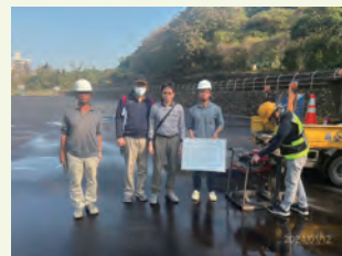
操場整修施工
